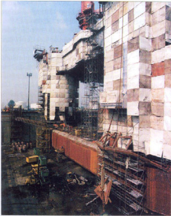
Abbildung 1: Arbeitsinsel im Trockendock
